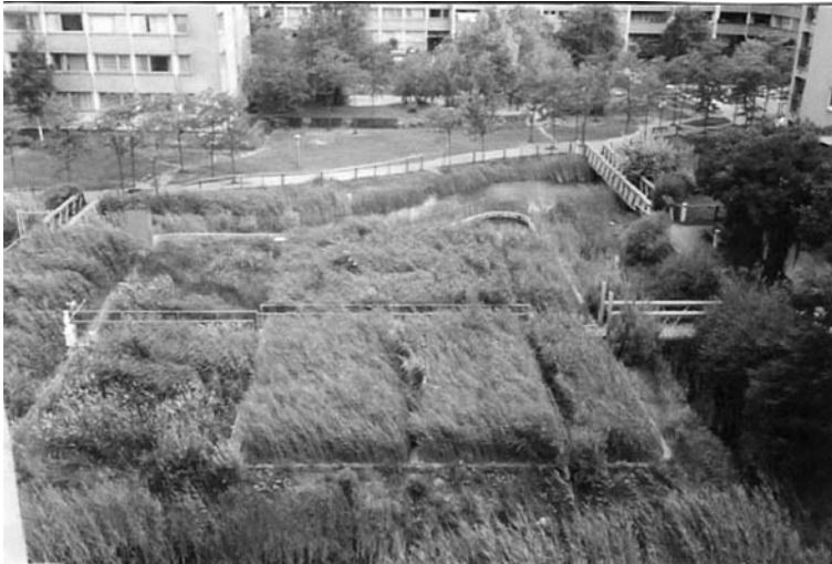
Sistema di fitodepurazione HF per le acque grigie
