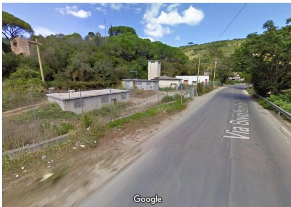
Stazione acquedotto Il Piano a Rio Marina
